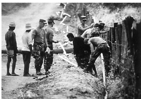
Рис. 2. Прокладка трубопровода военными США в одном из населенных пунктов
